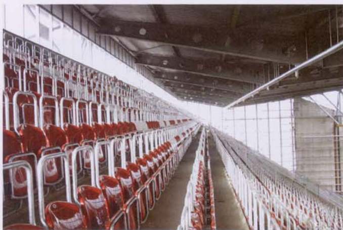
Umbau der Tribünen nach FIFA-Sicherheitsstandards
